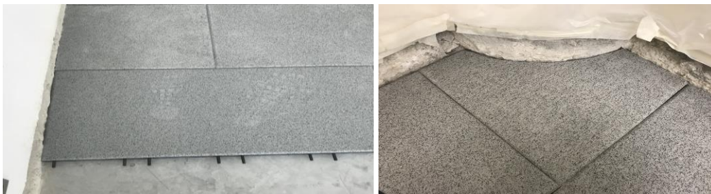
Die zweite Reihe um eine halbe Platte versetzt beginnen; Zuschnitt einer Rundung
