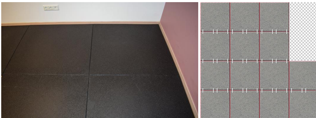
Platten zusammendrücken; Verlegung der Platten im Schachbrettmuster
